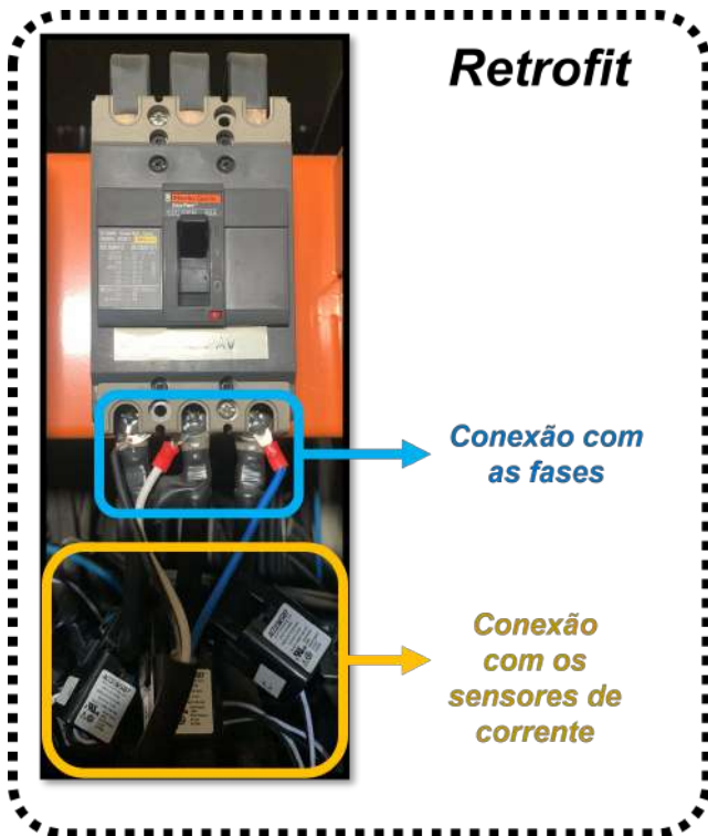
Figura 4. retrofit dos circuitos do quadro de distribuição.
