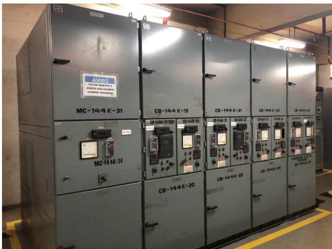
Fig. 2 Painel de 4,16 kV utilizado
