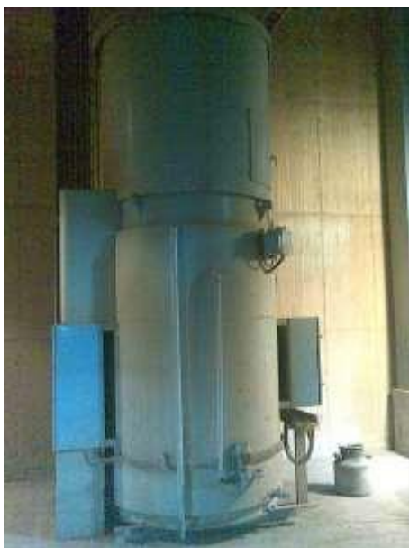
Fig. 2 Reostato líquido de partida.
