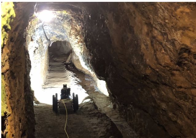
Figura 1. EspeleoRobô sendo operado via cabo durante a inspeção de um ambiente confinado.
