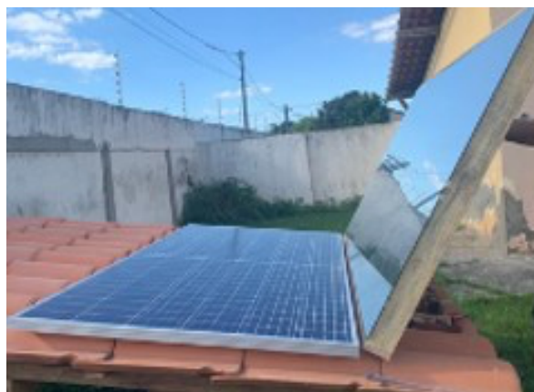
Fig. 7: Módulo instalado em um telhado simulado. Fonte: os próprios autores.
