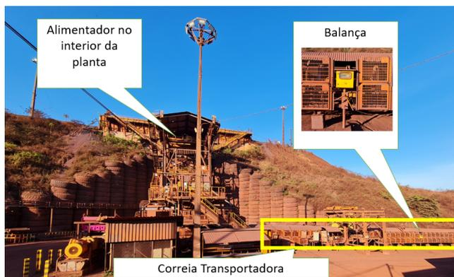
Figura 3. Alimentador e balança na planta BSM3 em Carajás, no Pará.
