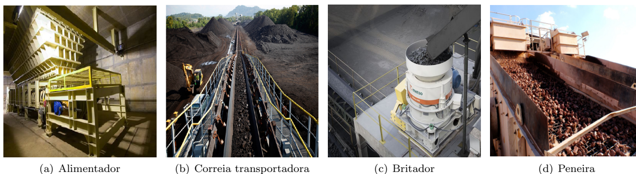
Figura 1. Principais equipamentos de um circuito de britagem.
